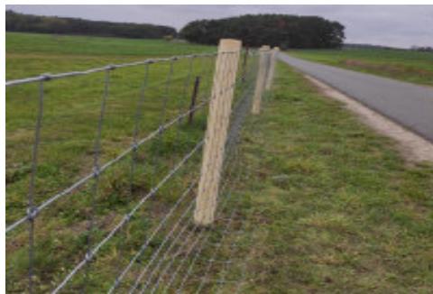
Beispiel für einen Festzaun, hier mit Robinienpfählen
