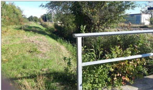
Abbildung 2.8: Branitz-Dissenchener Hauptgraben nördlich der Einmündung W-v-S-Straße in Branitzer Straße (011331)
