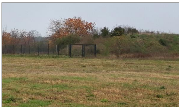
Abbildung 2.15: Lärmschutzwall zur B168 nordöstlich des Plangebietes
