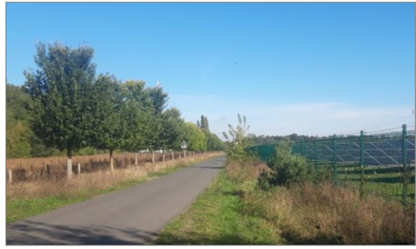
Abbildung 2.7: Branitzer Straße als westliche Plangebietsgrenze mit junger Baumreihe (westlich) und PVA (östlich)
